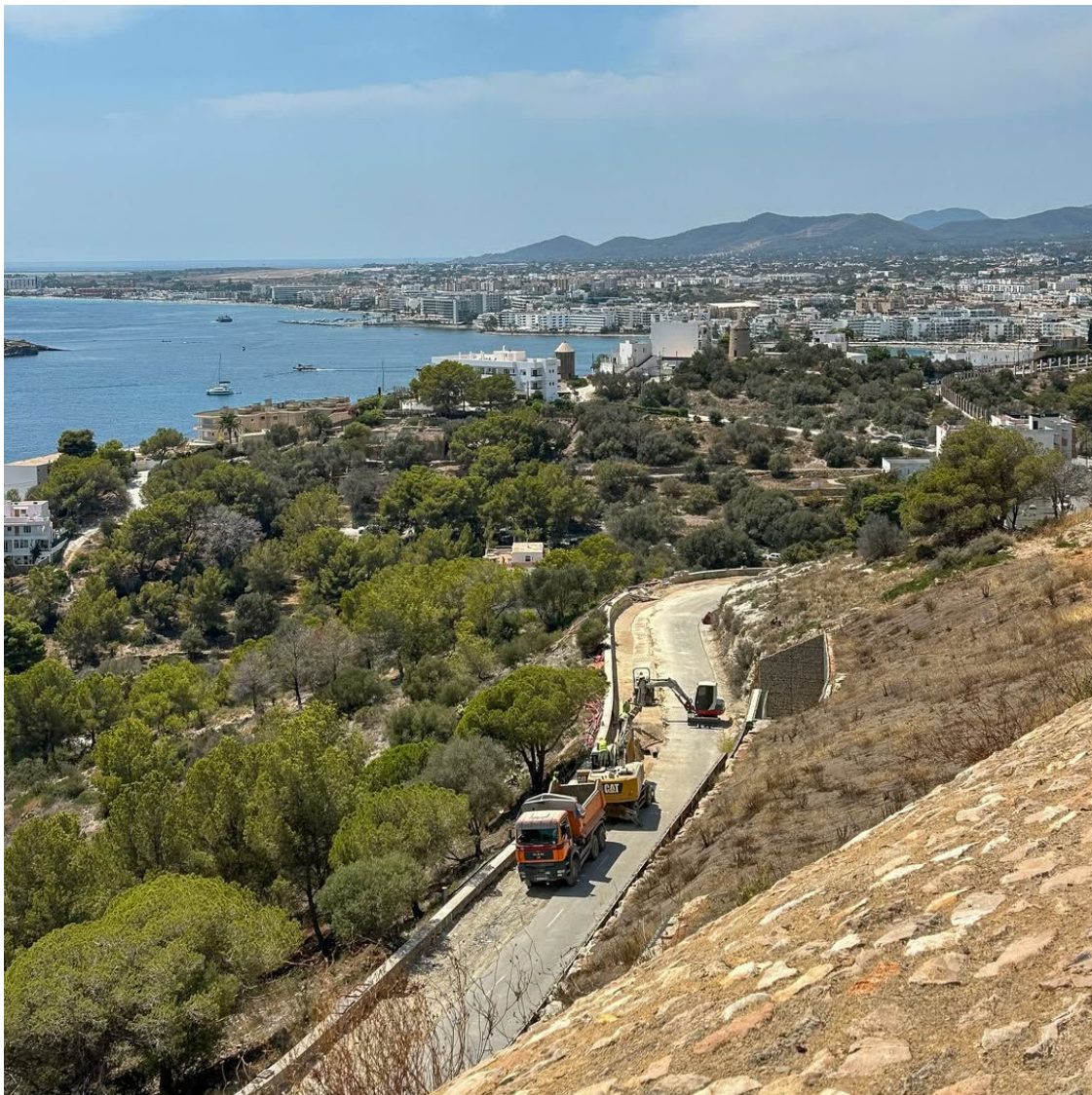
Obras en el Camí del Calvari
