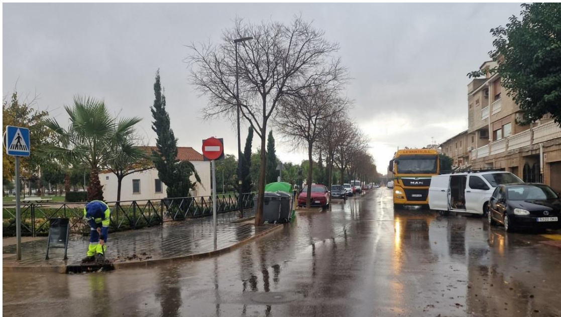
Trabajos de saneamiento en Albal con el objetivo de minimizar posibles riesgos. / A. A.
