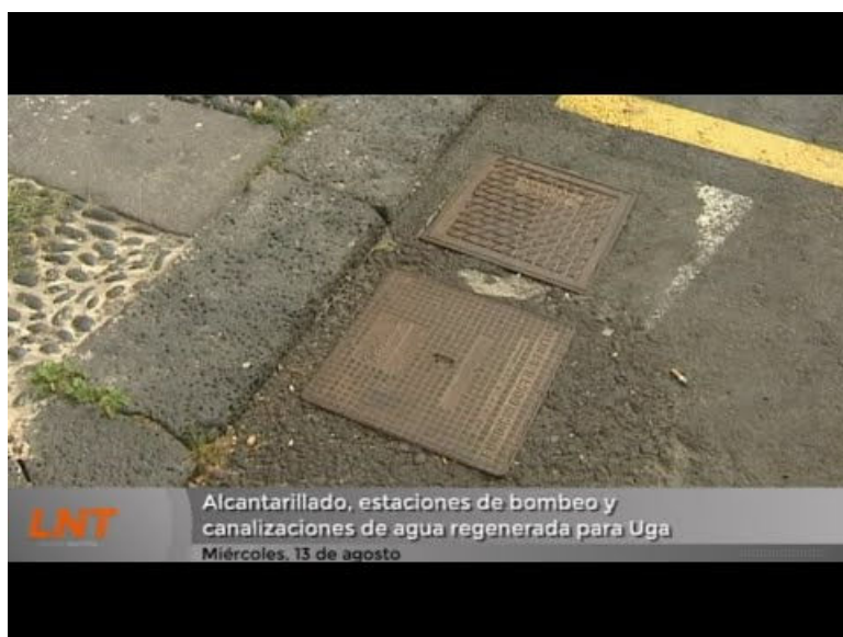
Alcantarillado, estaciones de bombeo y canalizaciones de agua regenerada para Uga
